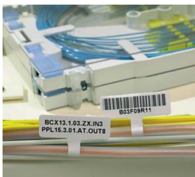
Fähnchen für Glasfaserkabel
